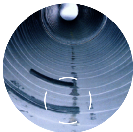
Kuva 3.3: Kanava, joka sisältää metallijauhetta yli 30 \text{ g/m}^2 .
